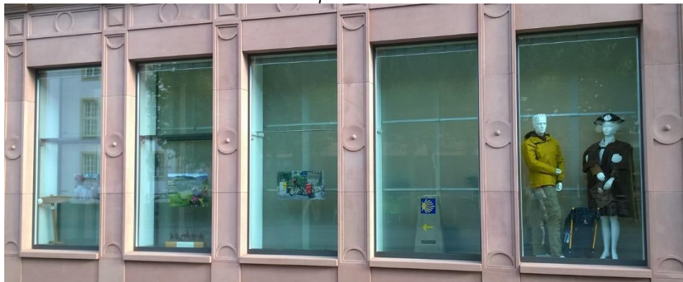
Fensterfront der Bank
