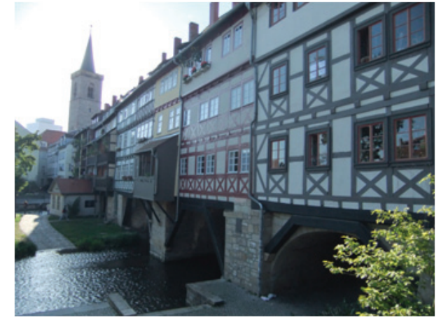
Krämerbrücke mit Wohnhäusern in Erfurt
