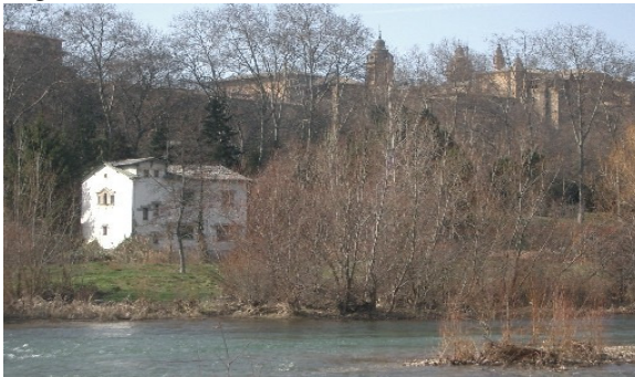
Pilgerherberge "Casa Paderborn" und Kathedrale
